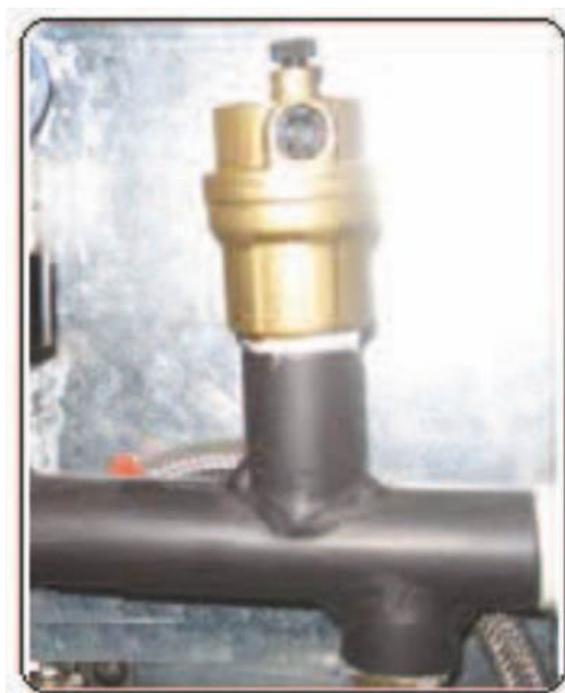
Фигура 3.10. Въздушен изпускателен клапан.
