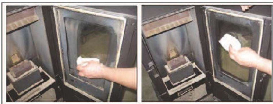
Фигура 6.3. Почистване на стъклото на камината.
